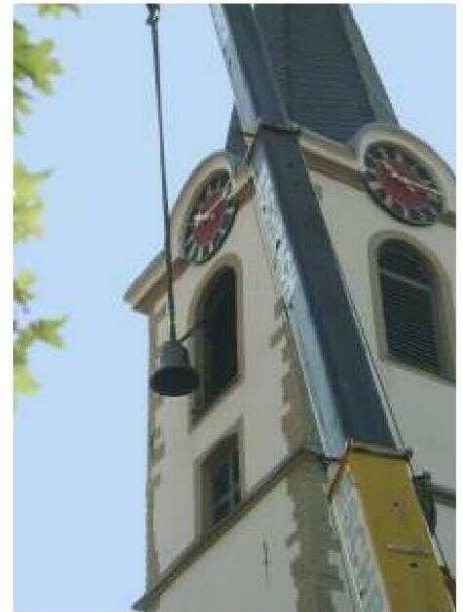
Einholen der neuen Glocken
