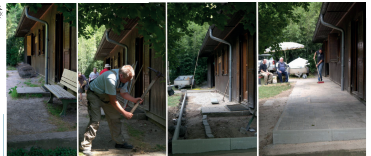
Aus den Pflastersteinen des Gemeindehauses Friedrichstraße entstand der Vorplatz der Hütte
