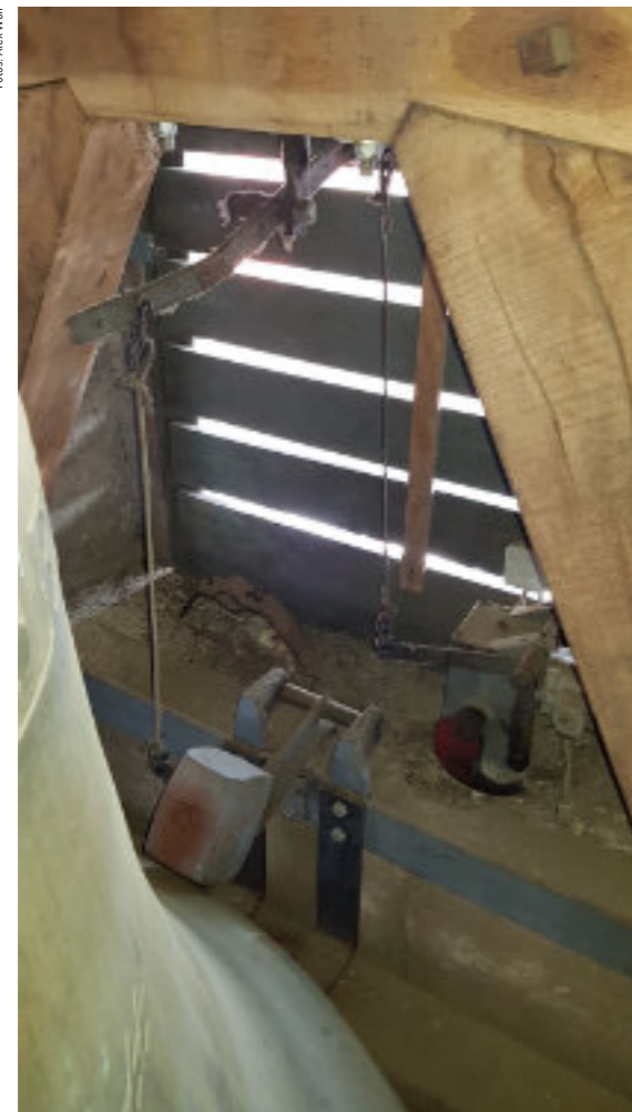
Motor - Welle - Zapfen - Stift - Schnur - Umlenkrollen - Hammer: Was es alles braucht für ein »Bim!«
