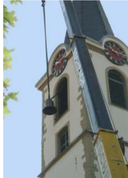
Einholen der neuen Glocken
