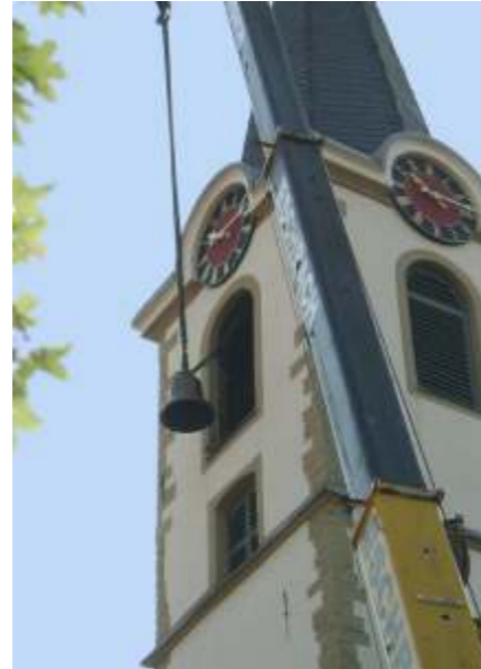
Einholen der neuen Glocken
